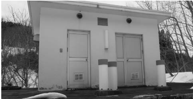
大滝簡易水道配水池
