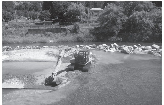
▲松岡頭首工で行われた河床整正工事の様子
