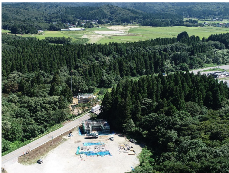
工事が本格的に開始された小国道路（山形県小国町） 写真提供：山形河川国道事務所
