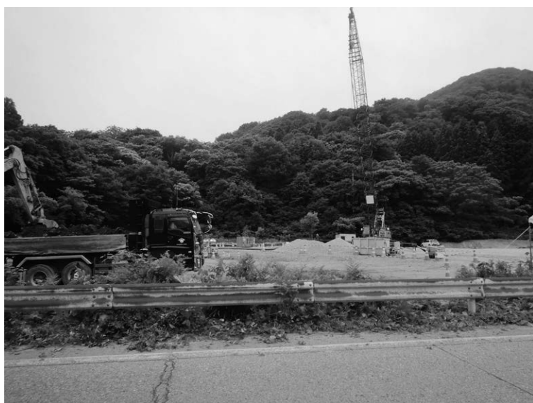
進む高規格道路工事
