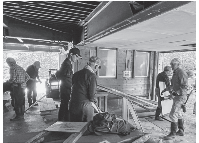
▲看板や案内表示をセラピーロードに運搬、設置する
