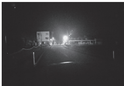
消えたままの小国大橋の街灯
