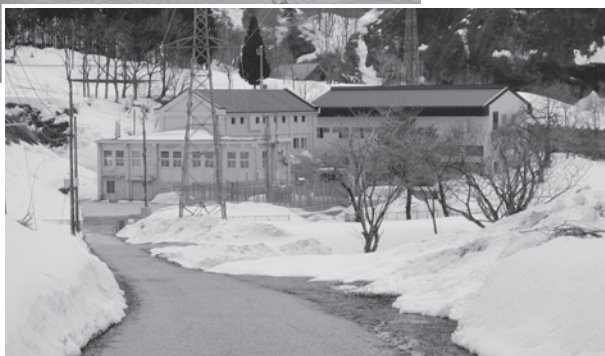
▲小国で最初にできた長者原発電所（水路式）
