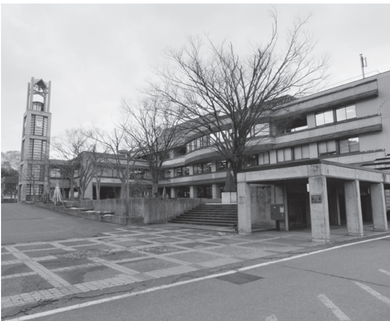
庁舎の損傷が目立つようになってきた
