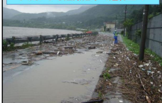
大雨による道路冠水で通行止め
