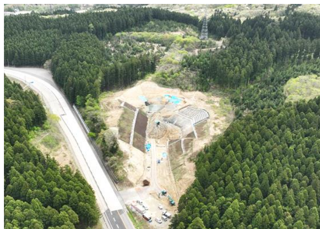
早期開通を目指して工事が進む鷹ノ巣道路（新潟県関川村）
