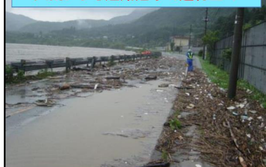
大雨による道路冠水で通行止め
