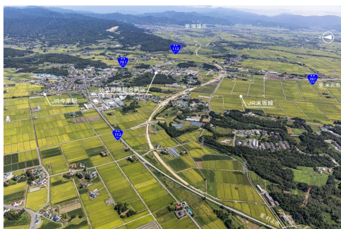
令和5年度開通予定の梨郷道路 川西交差点付近（山形県川西町、長井市）
