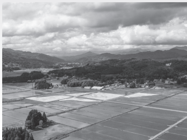
▲（仮称）小国ICの建設が始まる（令和5年6月撮影）
