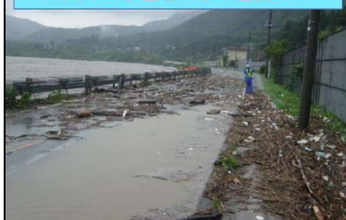
大雨による道路冠水で通行止め
