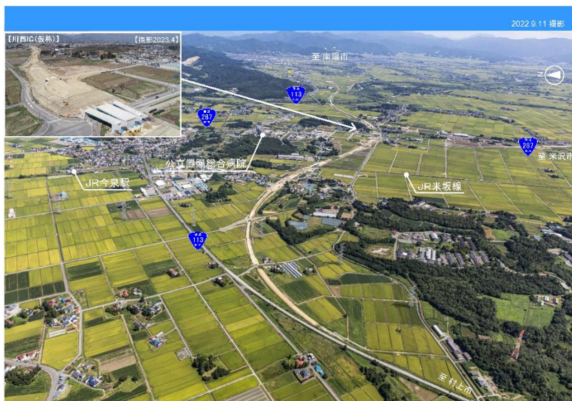
令和5年度開通に向けて工事が進む梨郷道路(仮称)川西 IC 付近 (山形県川西町)
