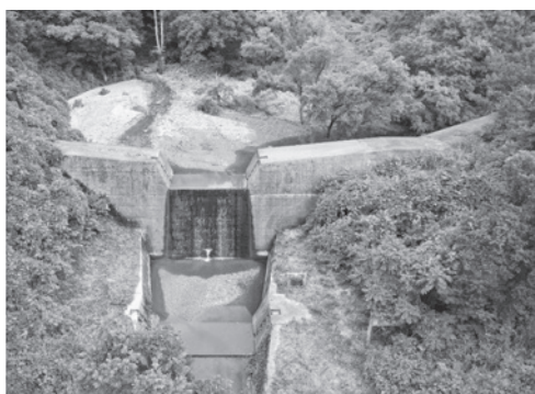
土砂を捕捉した小倉沢下流砂防堰堤(中野地先)
