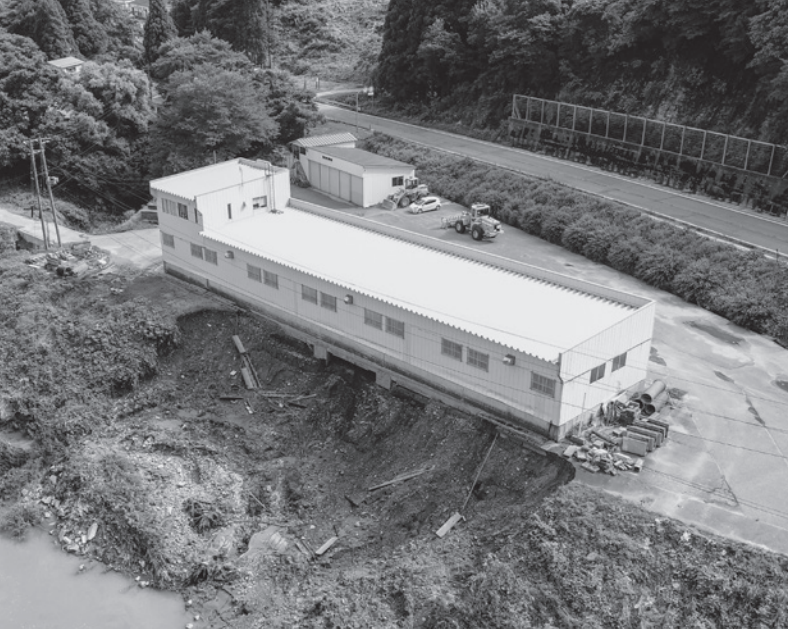
小国町除雪センター（令和4年8月撮影）
