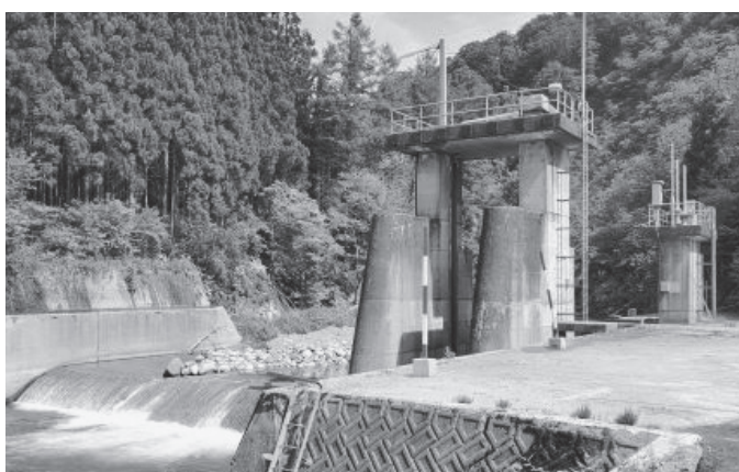
復旧工事後の井の下頭首工
