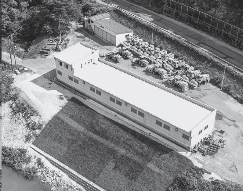
復旧工事が完了した小国町除雪センター（令和5年6月撮影）
