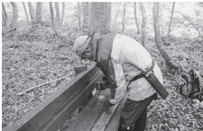
▲けもの道のベンチを修理する様子
