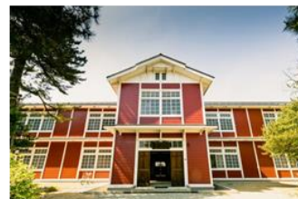
旧長井小学校第一校舎
