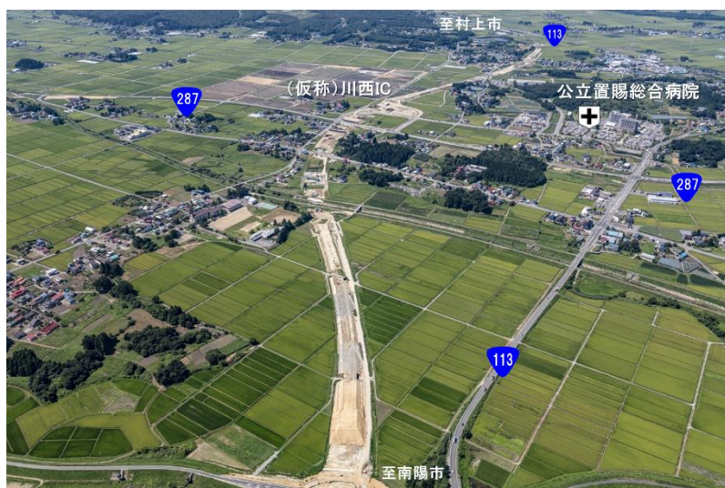
令和5年度開通に向けて工事が進む梨郷道路(仮称)川西 IC 付近 (山形県川西町)
