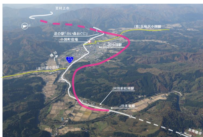
道路・構造物設計、用地買収等が進み、今年度より 工事に着手している小国道路(山形県小国町中心部)
