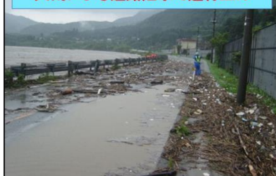
大雨による道路冠水で通行止め
