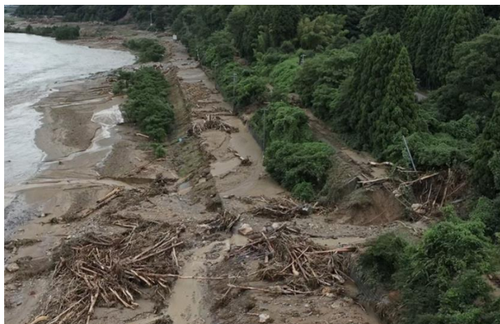
土砂流木堆積（新潟県村上市花立地内）
