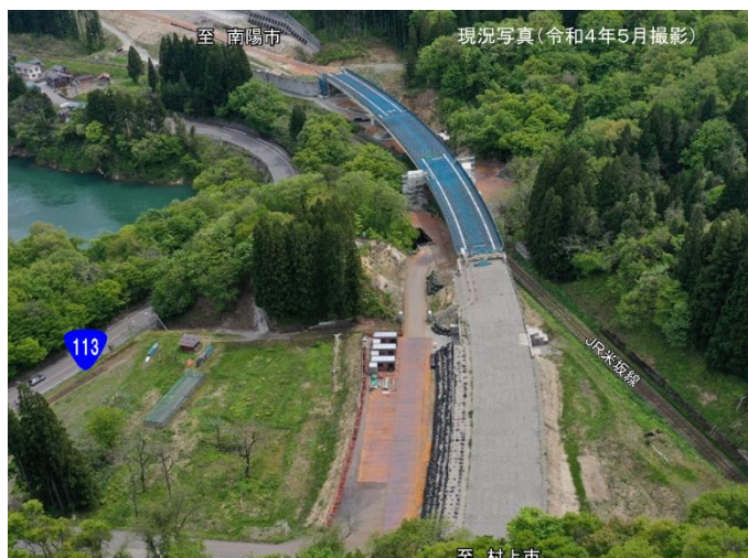
早期開通を目指して工事が進む鷹ノ巣道路(新潟県関川村)
