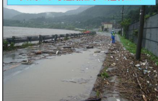
大雨による道路冠水で通行止め
