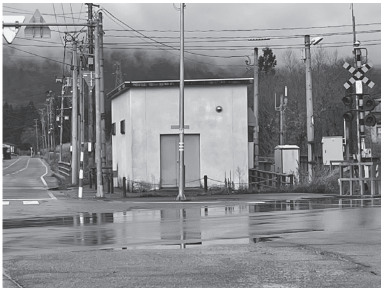
田沢川中継ポンプ場(西踏切)
