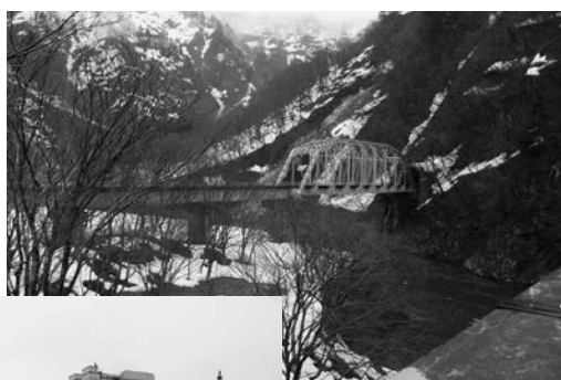
米坂線 冬の鉄橋
