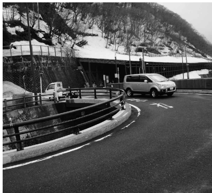
赤芝発電所ダム湖上にかかる梅花皮橋
