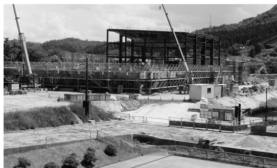
順調に進む小国小学校改築工事
