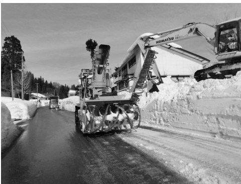
重機による除雪状況
