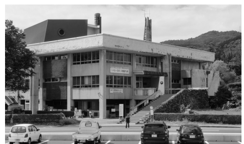
老朽化が進むおぐに開発総合センター
