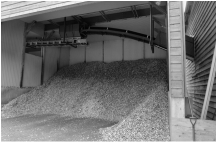
木質チップストックヤード
