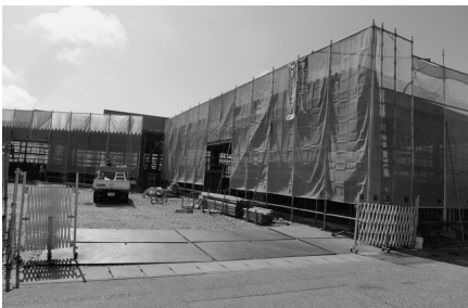
建設中のバス車庫
