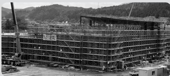
建設が進む新小国小学校
