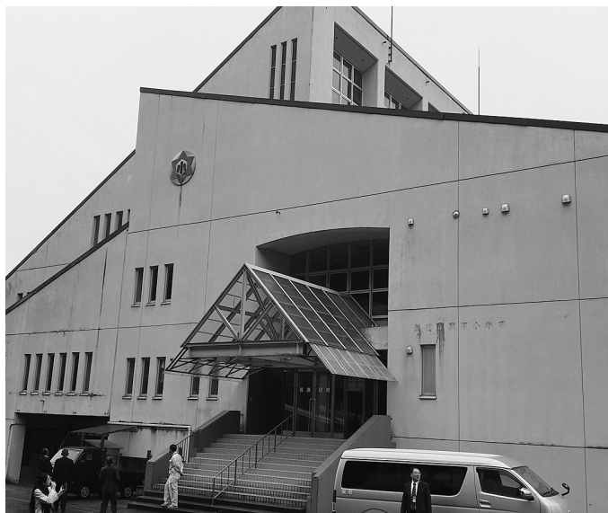
廃校舎を活用した長瀬団地
