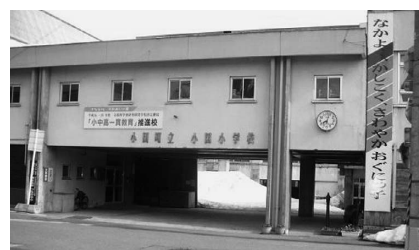
荒廃がすすむ旧小国小学校
