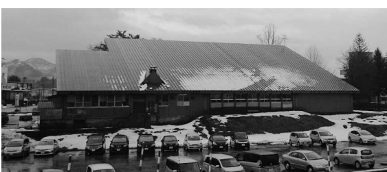
施設の老朽化が進むおぐに保育園
