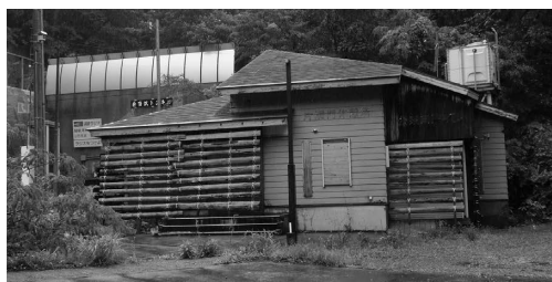
片洞門休憩所
