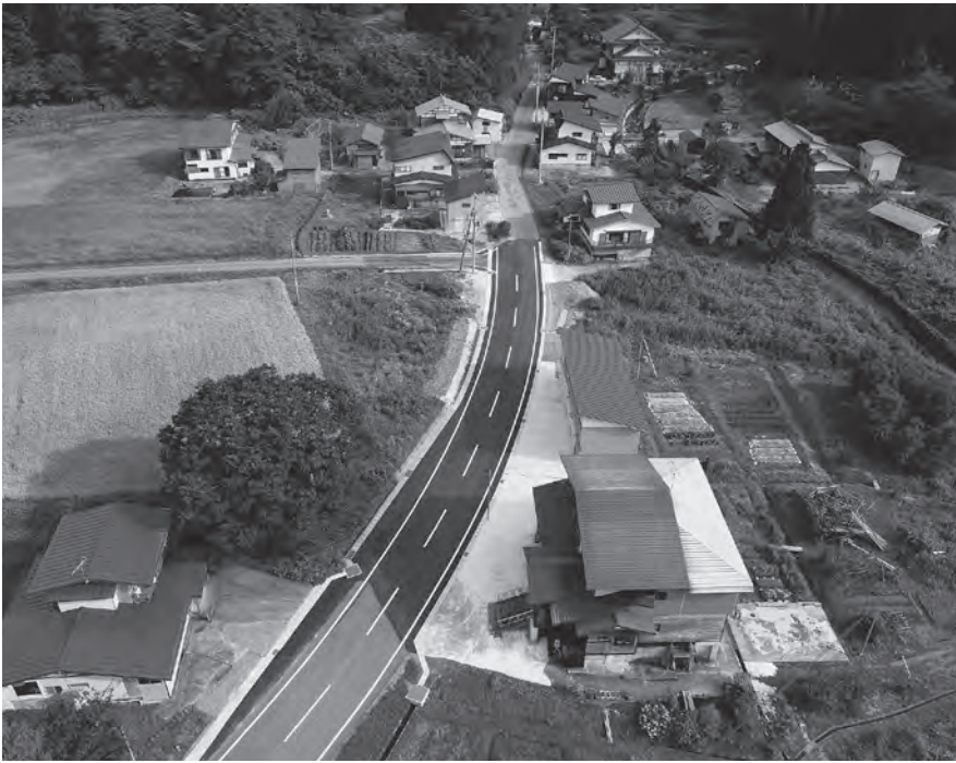
▲松岡黒沢峠線道路整備
