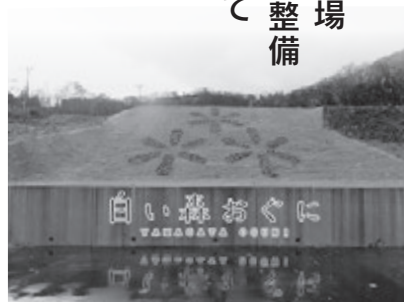
工事が進む道の駅花公園
