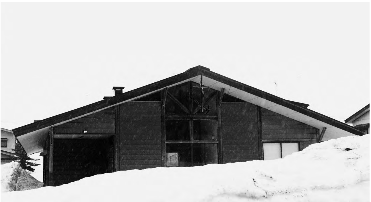
解体が予定されている「やまなみ寮」
