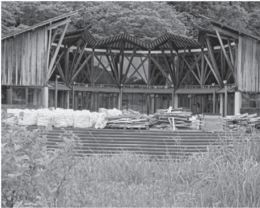
醸造所への改修が進み期待が膨らむ
