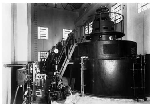
▲操業開始当時の発電機設備（昭和14年）
