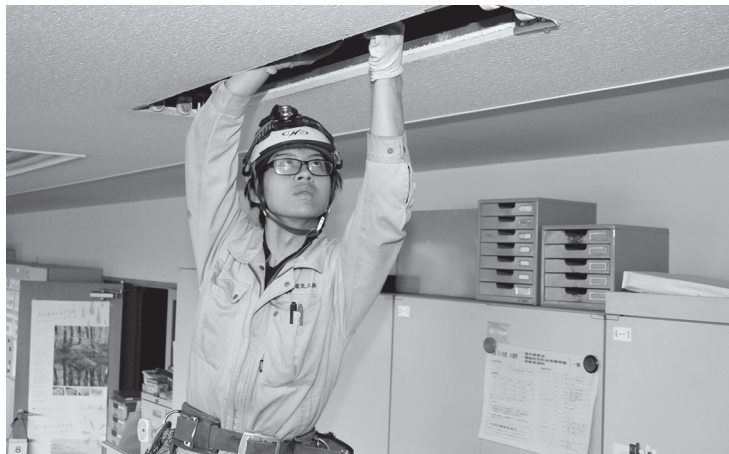
▲施設の電気設備工事をする四釜さん
