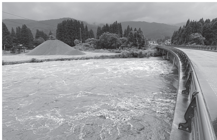
▲7月28日の大雨により増水した荒川（沖庭橋から）
