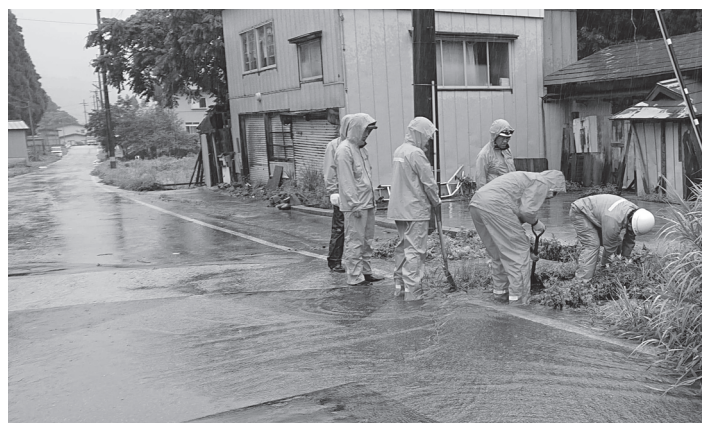
▲被害拡大を防ぐため、消防団が側溝の土砂を取り除いている様子【写真提供＝第2分団】
