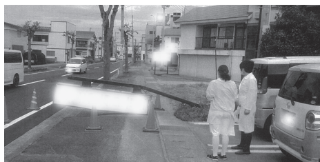
▲県内で発生した腐食による倒壊事故
