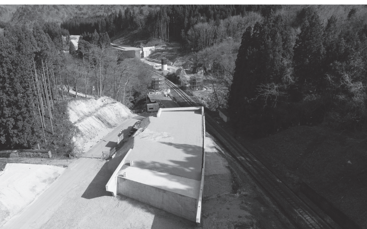
▲整備が進められている鷹ノ巣道路（大内淵地内）
