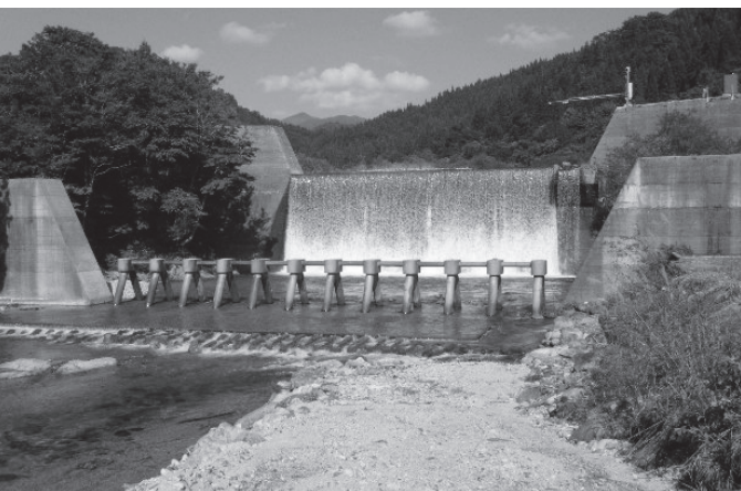
▲荒川上流部にある穴淵砂防堰堤
