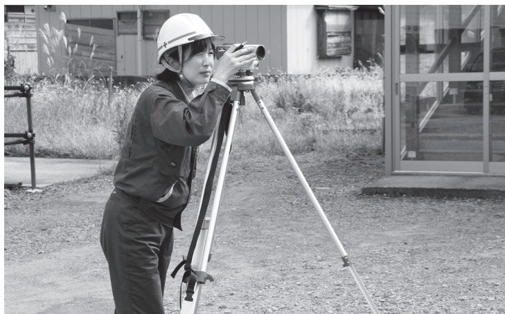
▲コンクリート打設工事の現場で測量をする須貝朝子さん
