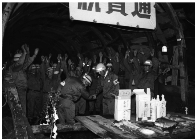
▲昭和44年9月17日横根山トンネル貫通
