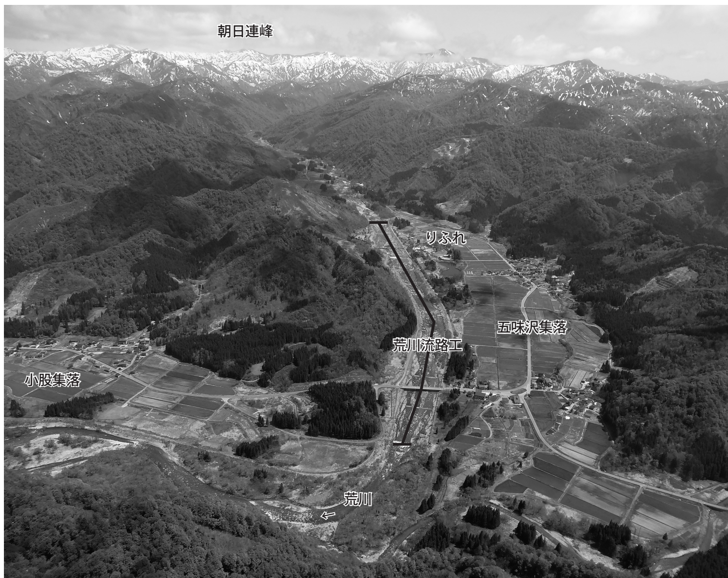
▲荒川流路工の全景（飯豊山系砂防事務所提供）
