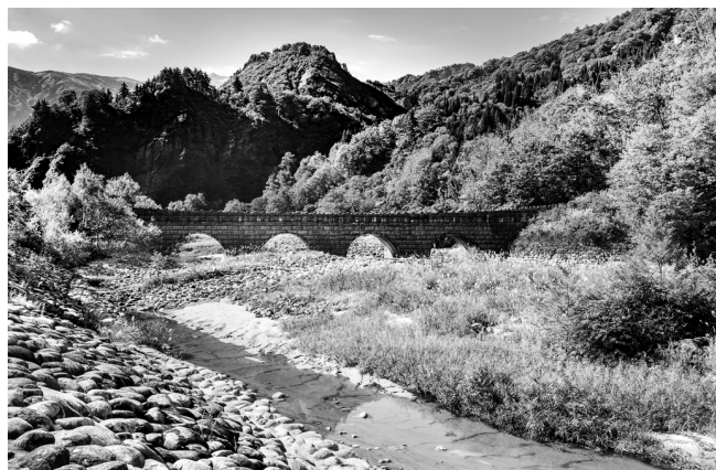
▲玉川スーパー暗渠砂防堰堤によって対岸に自由に移動できるようになった（小玉川）（飯豊山系砂防事務所提供）
