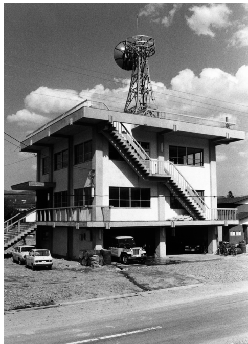
▲昭和44年4月に荒川砂防工事事務所が設置された
