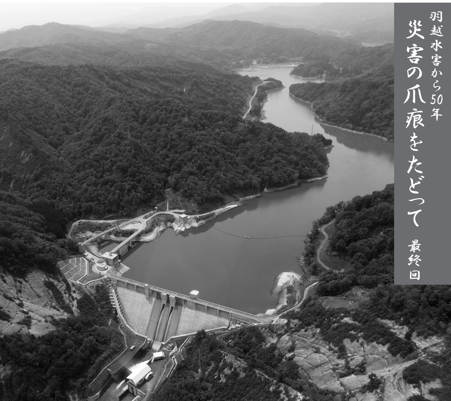
▲横川ダムとその周辺の様子（横川ダム管理支所提供）
