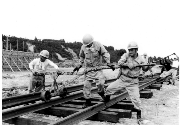
▲昼夜を問わず作業した工事関係者
