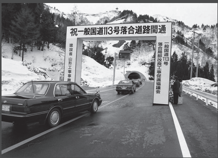
【平成6年】新宇津トンネル開通
