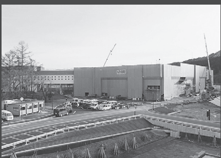
【平成25年】建設の進む小国小学校新校舎
