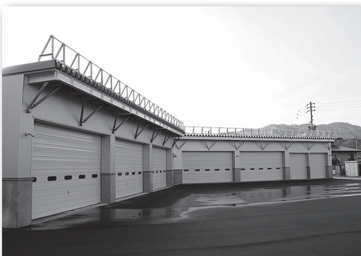
あけぼの地内に建設されたバスターミナル
