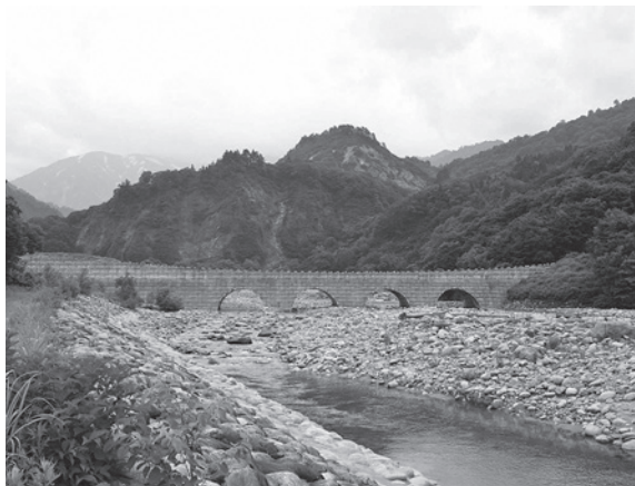
玉川スーパー暗渠（あんきょ）砂防堤防（小玉川地区）
