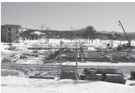
建設が進む新しい小国小学校
