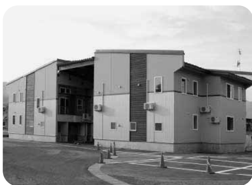
11月30日に完成した医師住宅
