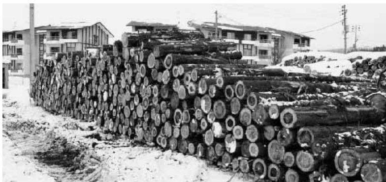
学校建設に使用する木材の確保（あけぼの地内）
