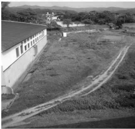
新校舎建設予定地周辺
