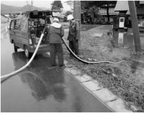
小型動力ポンプで排水作業を行う
