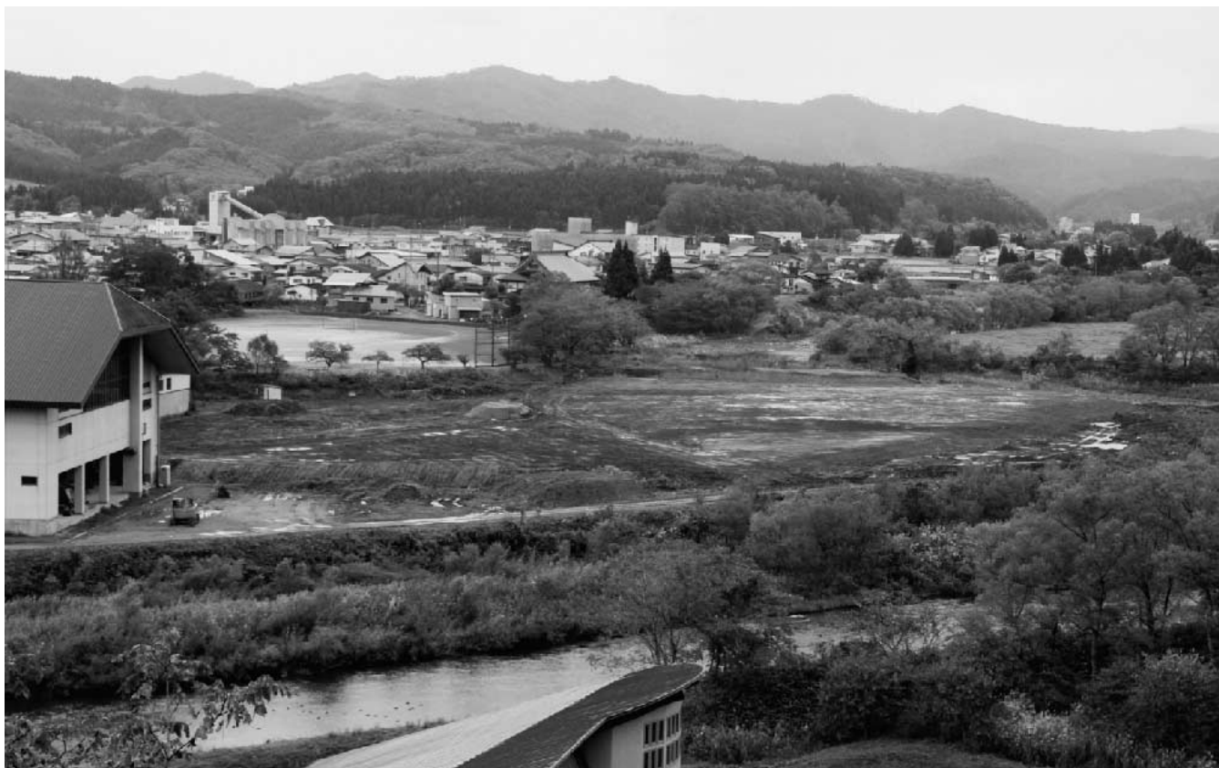
粗造成工事が進んでいる新小国小学校グラウンド部
