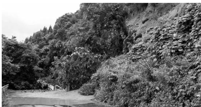
土砂崩れにより寸断された道路
