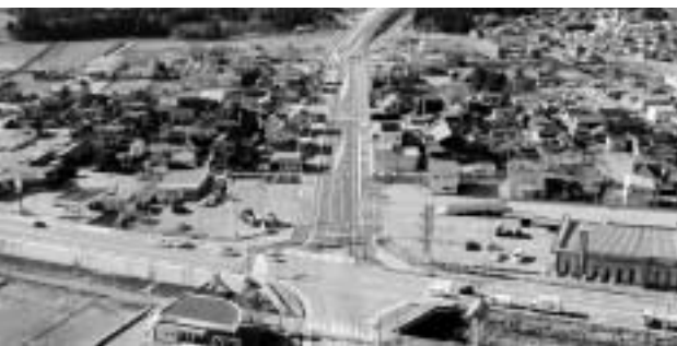
写真は、3月21日に開通した荒川道路（国道113号と国道7号の交差点付近） 町では、今後も新潟山形南部連絡道路の早期実現にむけ運動を展開
