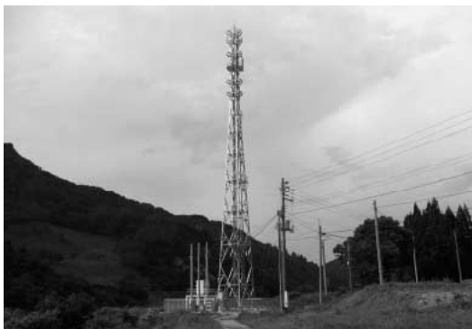
本年8月に大字小玉川地内に完成した移動通信用鉄塔施設
