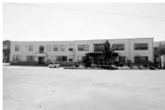
最先端の研究・技術開発を行う開発分析棟
