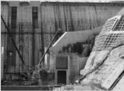
堤体の下に発電所の基礎が姿を現しました。その右上には、発電所に送水する管が見え、太さは中にダンプトラックが入る程です。
